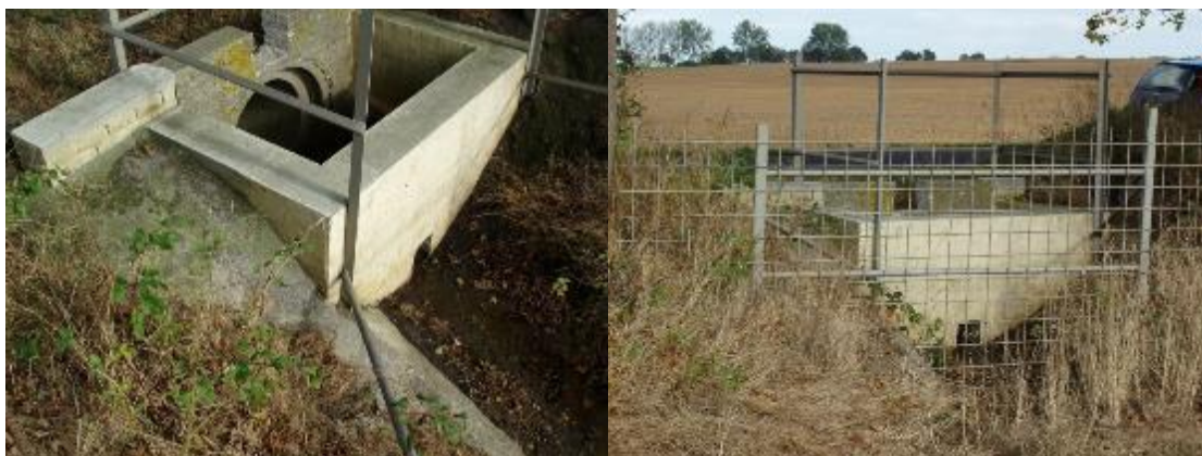
Figure 5 : rétrécissement des canalisations avec un limiteur de débit et une grille de protection. "Le but des différents aménagements antiérosifs est de filtrer l'eau et de la ralentir. Vouloir bloquer l'eau c'est contreproductif: elle finira par trouver un autre chemin et fera encore plus de dégâts." Source commune de Donceel
